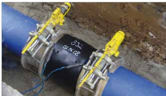
Obr.: Zakružovací svěrky pro elektrotvarovky. Zdroj: +GF+
