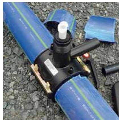
Obr. 3 Přesným umístěním navrtávací objímky se zajistí čisté svarové spojení v souladu s DVS směrnici.
