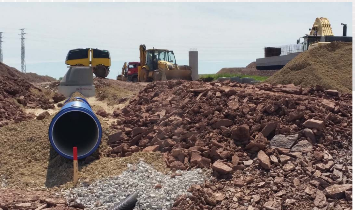
Dálnice D3, Úsilné- Bošilec
