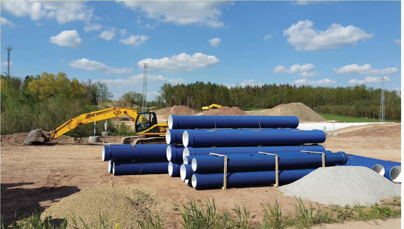
Dálnice D3, Borek - Úsilné
