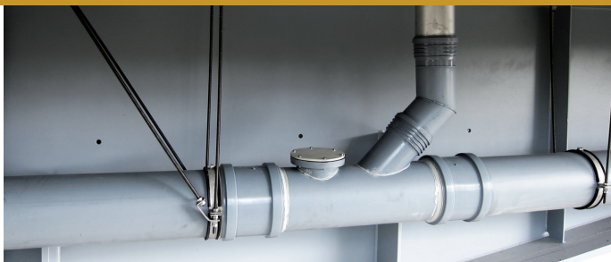
Príklad napojenia cestného odvodňovača na zberné potrubie
