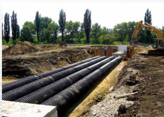
Retencia vytvorená z niekoľkých potrubí Uporol o dimenzii DN 800 z dôvodu nedostatočného krytia (areál firmy Sony v Nitre, Slovensko).
