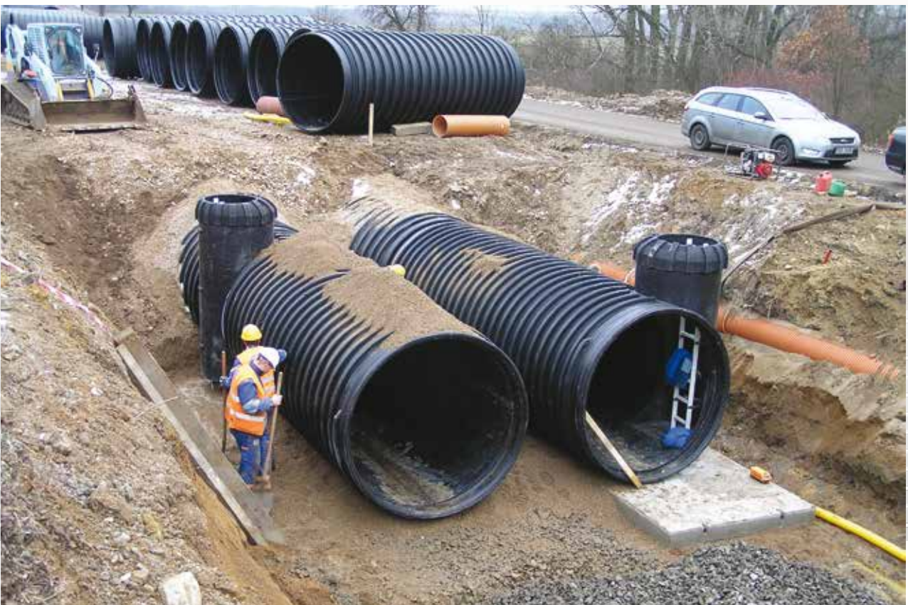
Retenčná nádrž z dvoch potrubí DN 2000 s ruksakovými vstupnými šachtami (diaľnica R7, Bítovceves – Vysočany).
