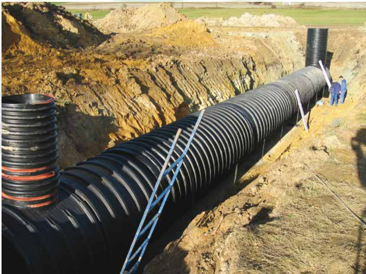
Prečerpávacia nádrž z potrubia DN 2000 a kotvením na betonovej doske z dôvodu vysokej hladiny spodnej vody a malého krytia (priemyslová zóna Domažlice).
