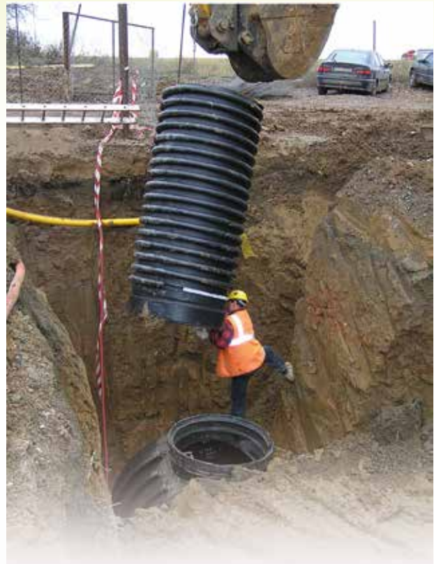
Pri väčších hĺbkach je vstupný komín rozdelený a jeho montáž sa robí až na stavbe pomocou hrdlového spoja.
