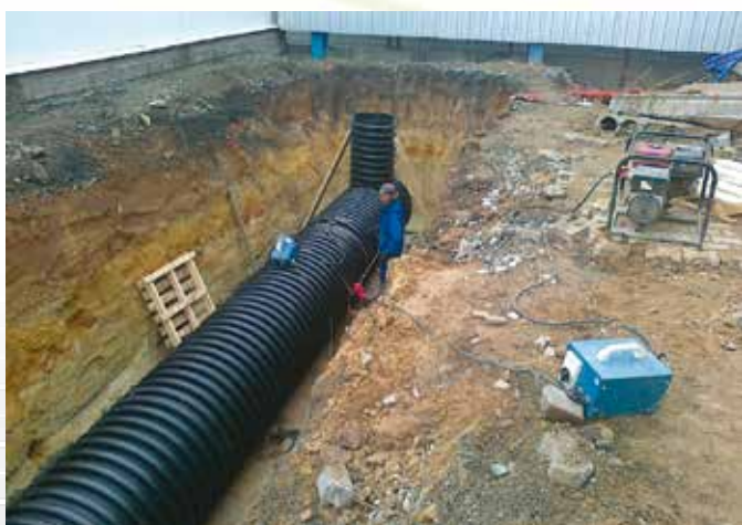
Bezpečnostná nádrž na ropné látky v prípade havárie. Tu bola kľúčová absolútna dlhodobá tesnosť, ktorá sa dá overiť opakovane tlakovou skúškou (areál firmy Kopos v Kolíne).
