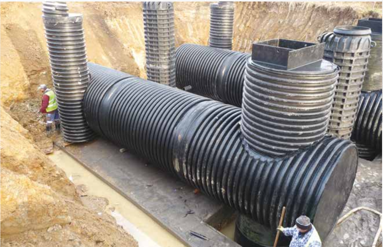
Vodojem s kapacitou 53 m 3 z dvoch potrubí DN 2000 vrátane vstupov a kalových nádrží (Mitrovica na Táborsku).
