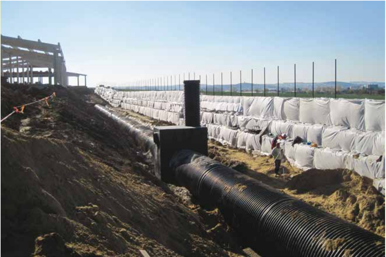
Retenčná nádrž z potrubia DN 2000 so stredovým výtokom opatreným vírovým ventilom (diaľnica R1 Nitra – Tekovské Nemce, Slovensko).
