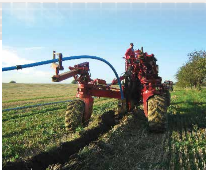
Pluhování je neefektivnější metodou pokládky pro dlouhé úseky vodovodů nebo tlakových kanalizací ležících v nezpevněném terénu.
